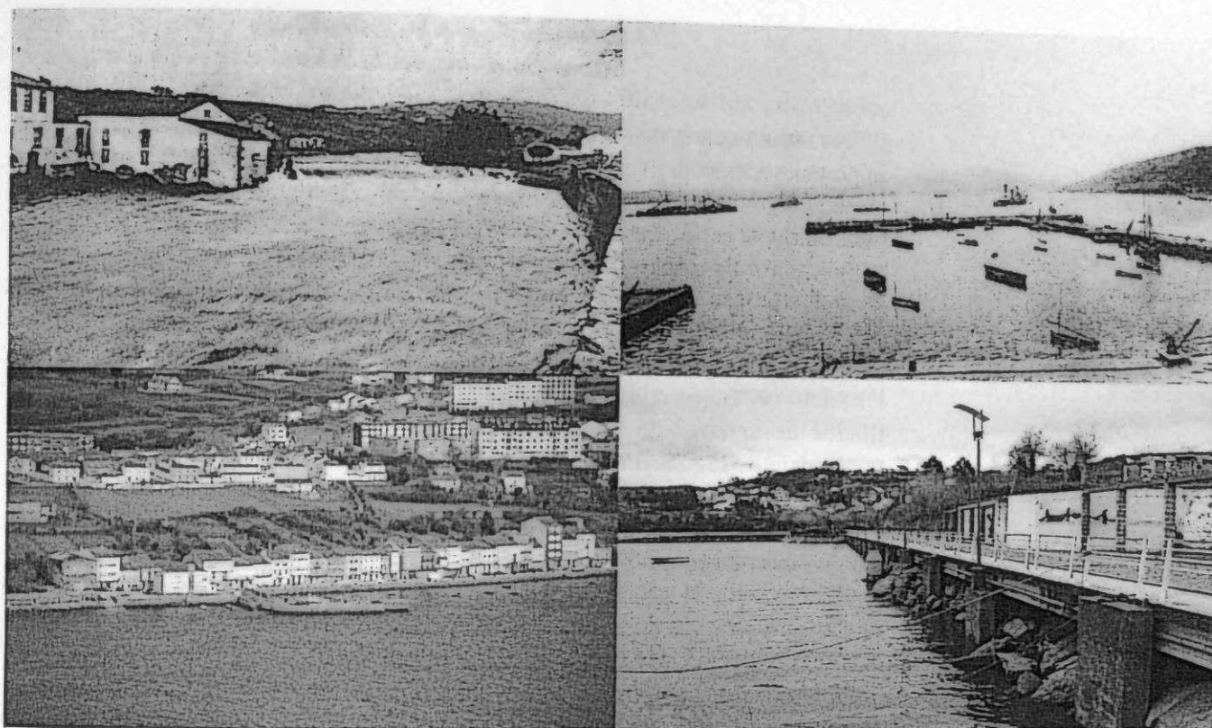
Catro imaxes de construcións dunha á outra beira da Ría: arriba esquerda, Desbordamento do río Xubia; arriba dereita, instalacións portuarias civís; abaixo esquerda, porto de Mugaros e abaixo á dereita, paseo de Maniños.
